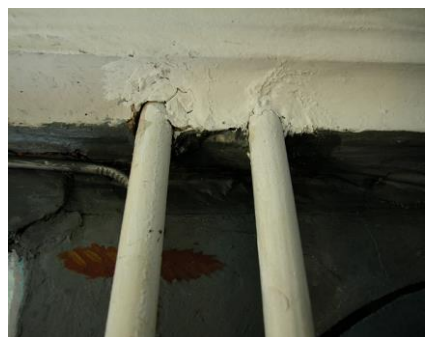
Bild. Efter åtgärder där nytt papp limmats fast där material saknades och sedan målats i passande kulör. (2632)
