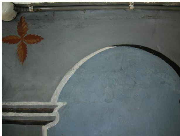
Bild. Vägghpartiet väster om dörren efter åtgärder. (2587)
