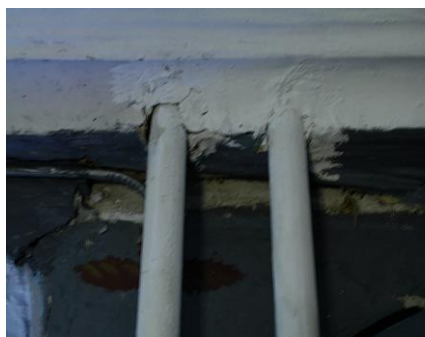
Bild. Kylejpen togs bort och det visade sig att delar av pappersremsan sakades. (2395)
