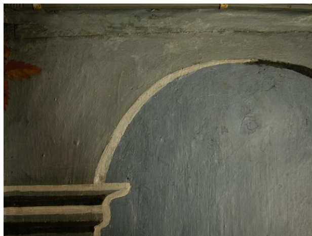
Bild. Efter konservering där de lösa färgflagorna återfästes med lim och där färgen flagat har fläckarna retuscherats med reversibel färg. (2602)
