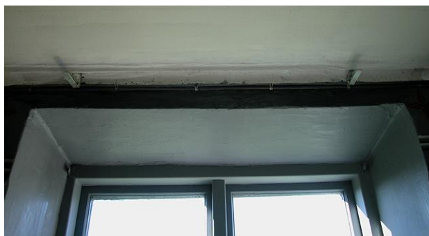
Bild. Kyltejpen har här avlägsnats liksom smutsen bakom taklisten och den lösa pappersremsan har fästes med nytt lim. (2612)
