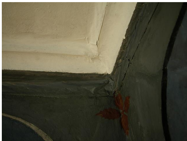
Bild. Vid konserveringen togs tejp bort och den lösa pappersremsan fästes med nytt lim och värme. (2634)
