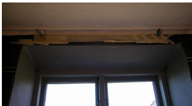
Bild. Det västra av de tvåfönstren på salens norra vägg. Den lösa pappen vid taklisten hade fästes med kyltejp eftersom det annars rasade ned sand som samlats bakom taklisten. (2388)
