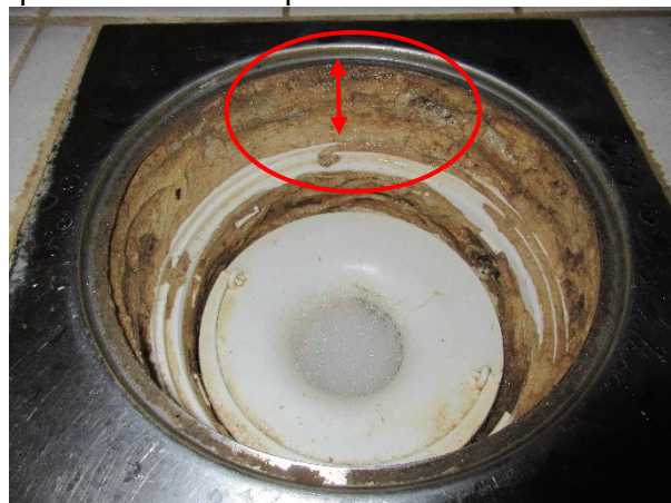
Fix och fog täcker anslutningen i golvbrunnen. Badrum på entréplan.
