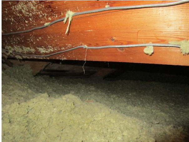
Vinden är tilläggsisolerad med lösull
