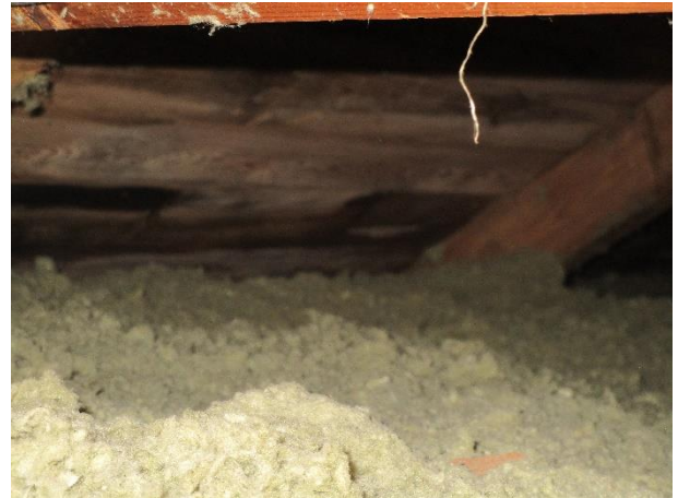
Mikrobielltilväxt längs yttertaket
