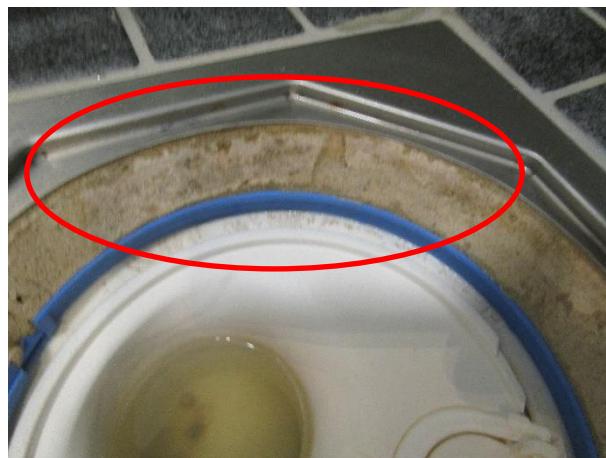
Fog och Fix täcker anslutningen till klämringen
