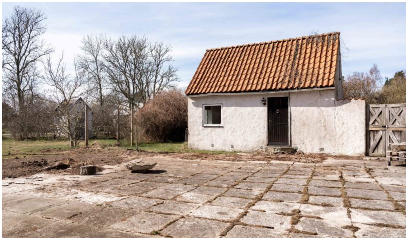
Flygelbyggnad om 19 kvm som uppfördes 1995. Här finns ett litet pentry och ett duschrum med wc samt allrum.
