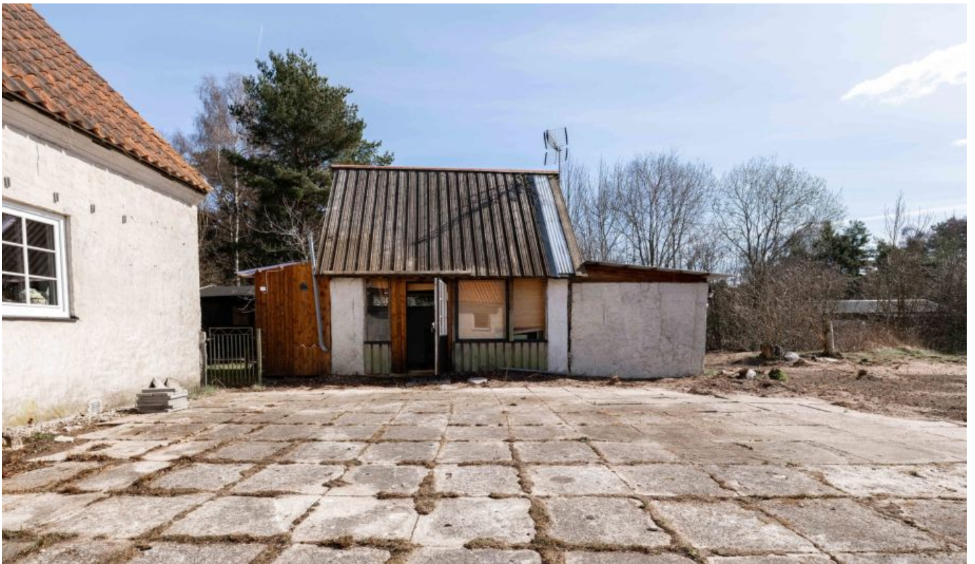
Uthus uppfört 2000 om 17 kvm. Här finns ett sommarkök och en övervåning som nås genom spiraltrappa.
