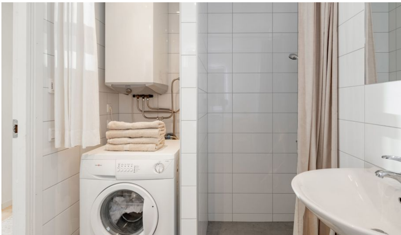
Helkaklat badrum från 2021 med golvvärme, dusch, handfat, toalett och tvättmaskin.
