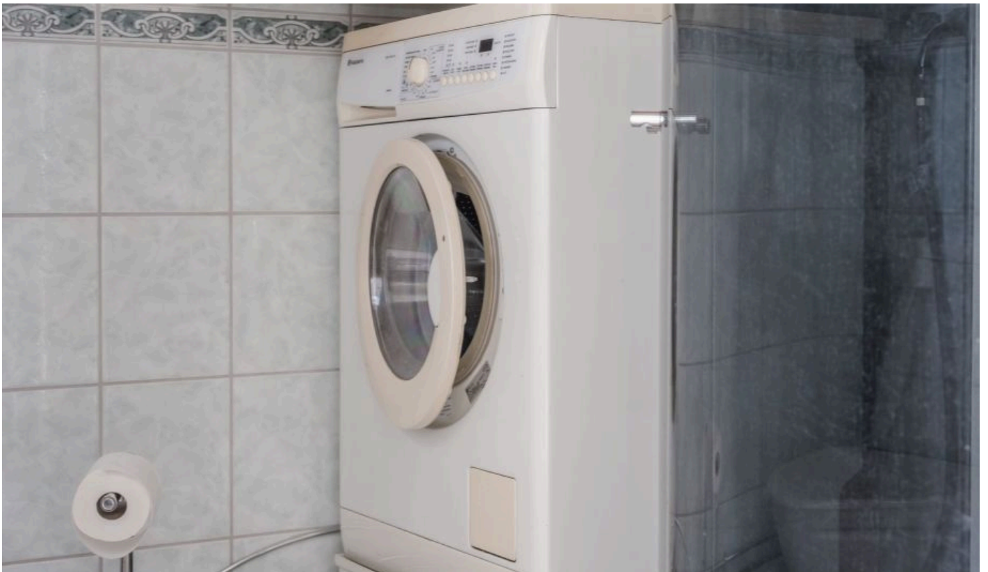
Badrum med toalett, dusch och tvätt.
