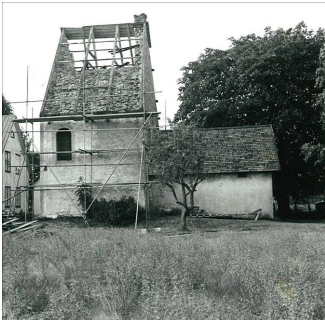
Omläggning av taket. Notera skorstenen som rivs i samband med detta. Foto Gunnar Svahnström 1969.
