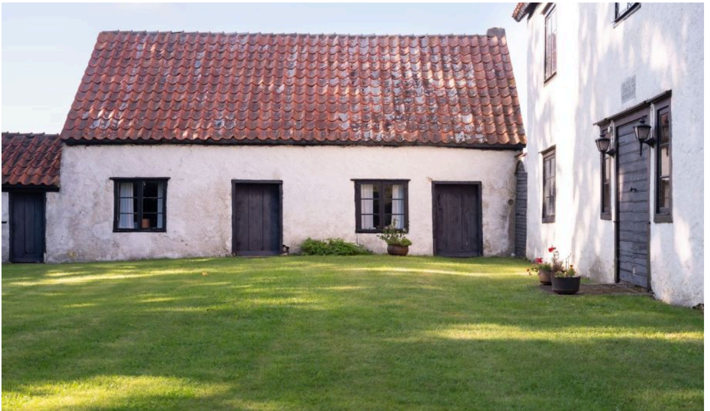
Flygeln (byggnad 2) drängkammare med öppen spis.
