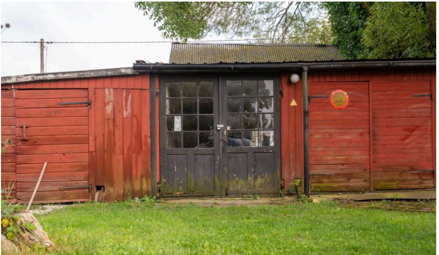
Smedjan (byggnad 3) samt garage (byggnad nr 6).
