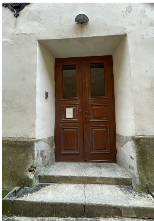
Gjuten trappa på södra fasaden
