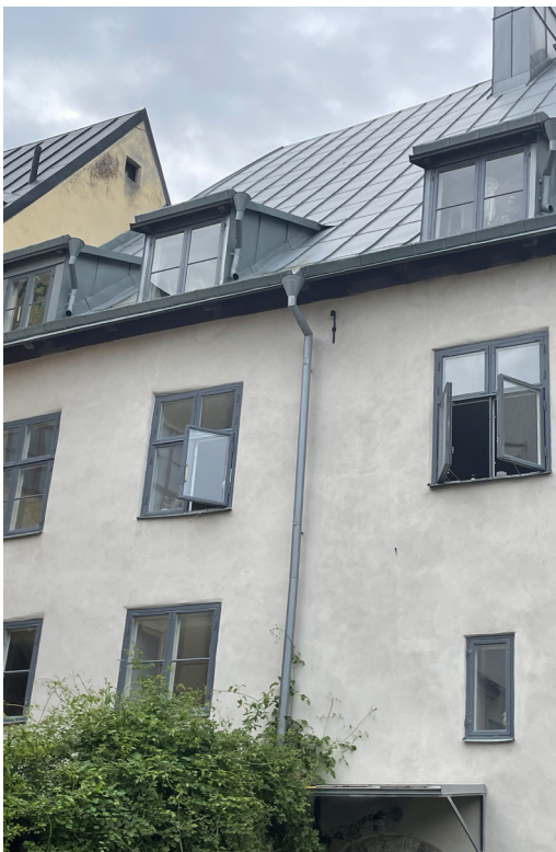
Fönster på lågdelens norra fasad
