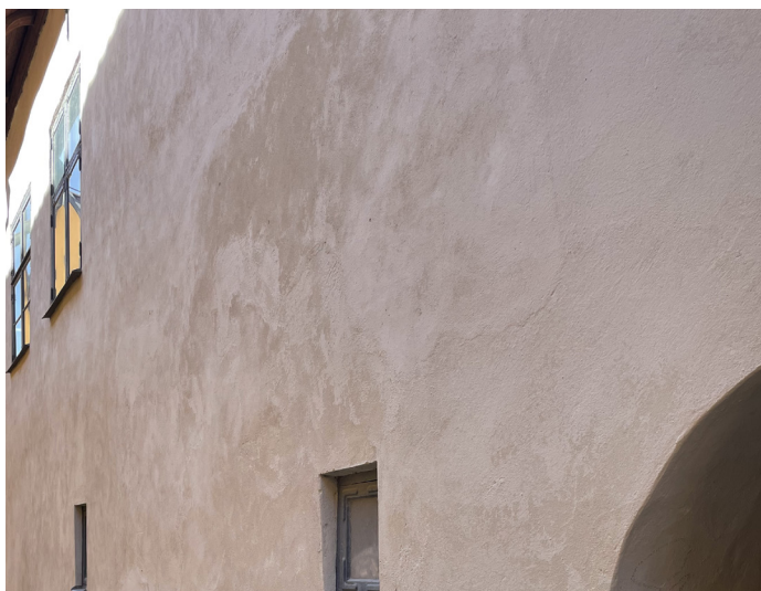
Fasad åt söder
