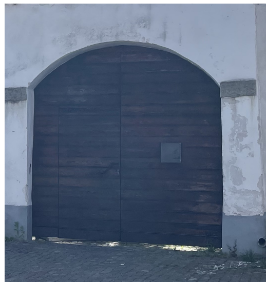
Tjärad träport med gångdörr i muren
