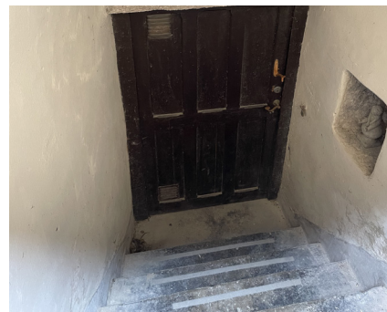
Gjuten trappa på södra fasaden
