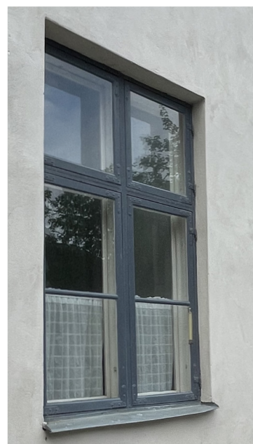
Fönster på norra fasaden
