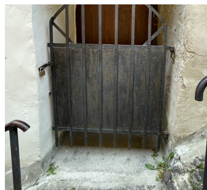
Gjuten trappa på södra fasaden
