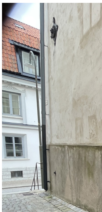
Stuprör och vandalrör på norra fasaden
