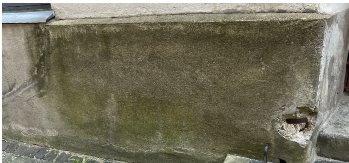
Sockel på södra fasaden med algpåväxt
