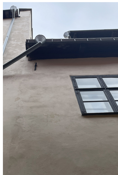
Takfoten på södra sidan av byggnaden
