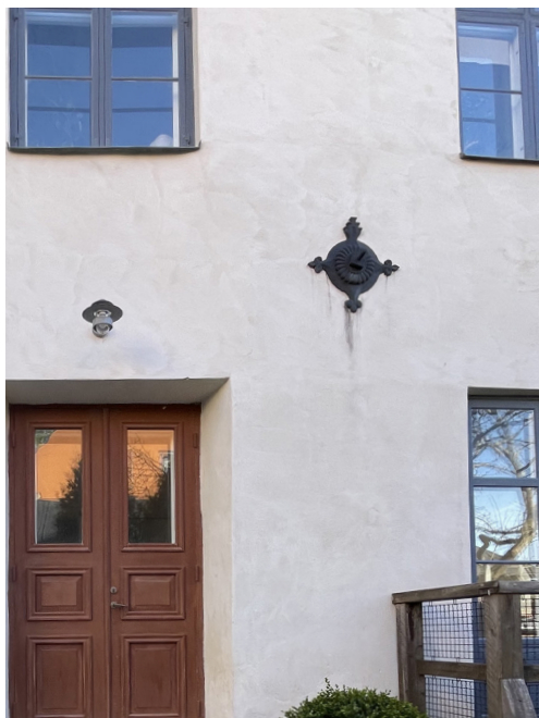
Ankarslut på norra fasaden
