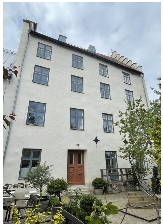
Fönster på högdelens norra fasad
