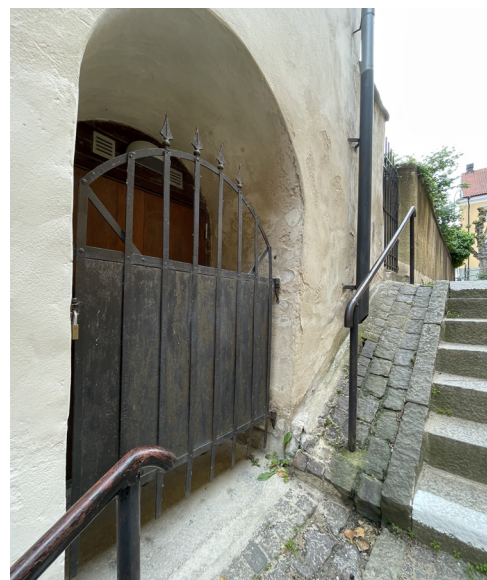
Källardörr på södra fasaden
