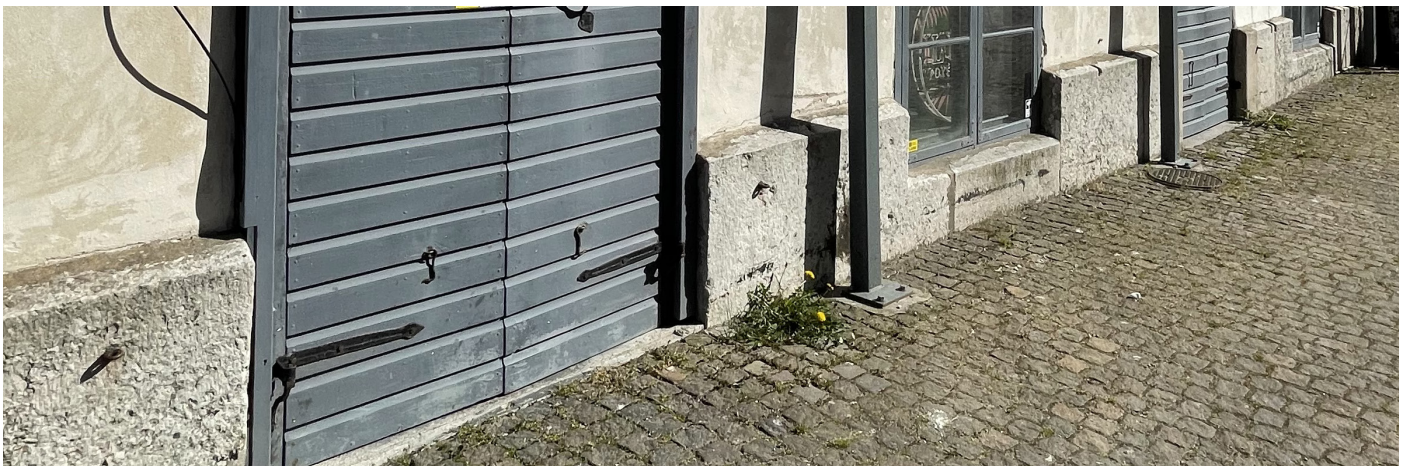
Kalkstenssockeln på den västra fasaden
