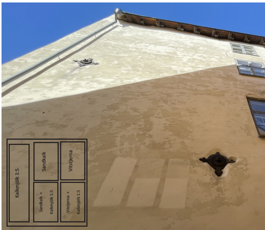
Södra fasaden med putsprover från åtgärderna som utfördes 2017
