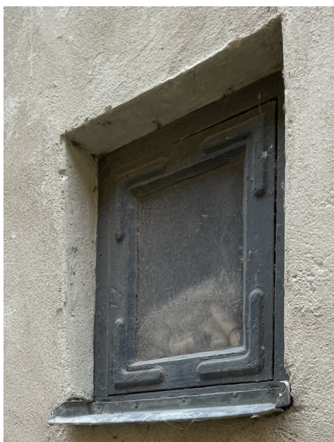
Mindre fönster på södra fasaden
