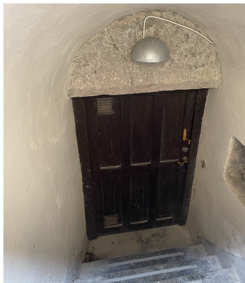
Källardörr på södra fasaden
