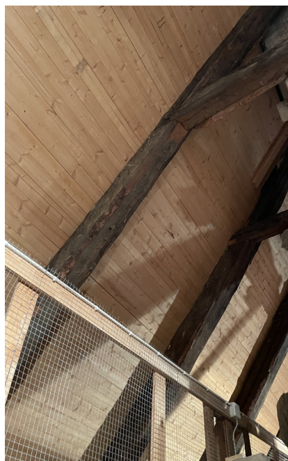
Norra takfallet sett från vinden
