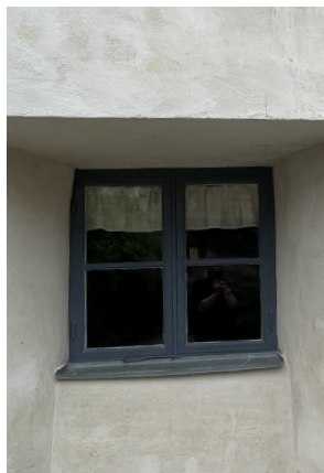
Fönster på lågdelens norra fasad
