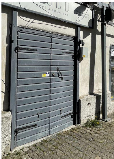
Tvåbladigt dörrpar på södra fasaden
