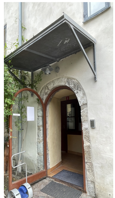
Kalkstensomfattningar samt skärmtak på norra fasaden
