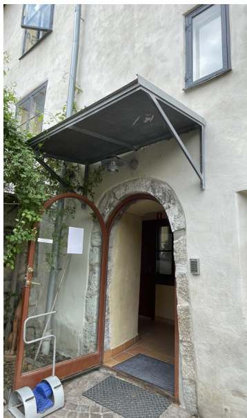
Port med stålram på norra fasaden
