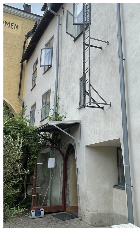
Stuprör på norra fasaden
