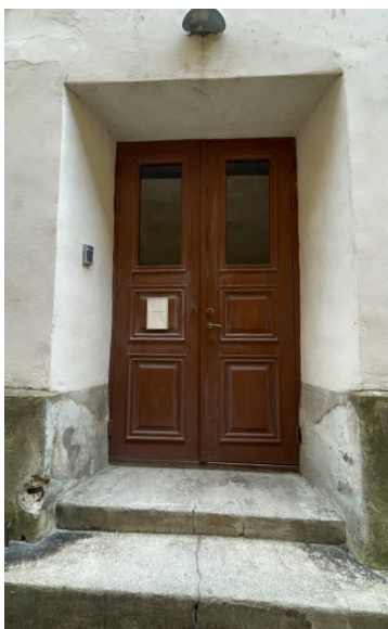
Pardörr på södra fasaden
