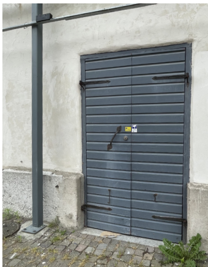
Tvåbladigt dörrpar på södra fasaden
