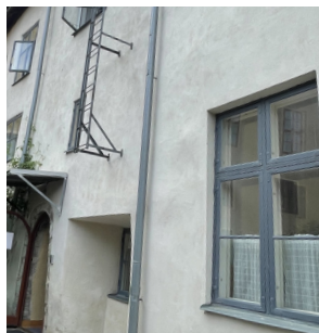
Fönster på lågdelens norra fasad
